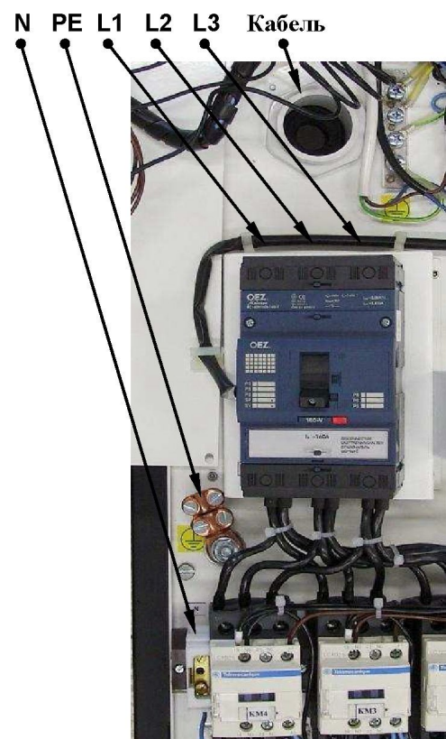
Рис. 21. Подключение входного кабеля котла «Daline PTE 22 – 60»
